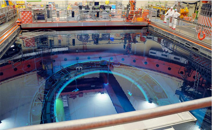
Blick in das Reaktorbecken mit offenem Reaktordruckbehälter während der Revision, Quelle: <https://www.kkl.ch/kernenergie/unser-kraftwerk/gebaeude-und-komponenten/reaktorgebaeude-und-reaktor>
